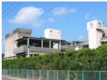
総合排水処理システム
