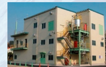
医薬生産工場完成(平成18年)
