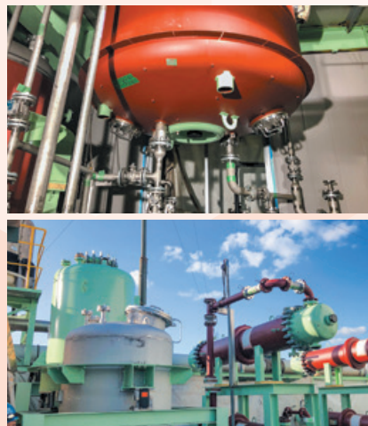
増設中の工場設備
