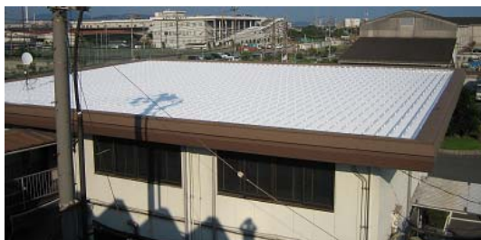
〔屋根の遮熱塗装と窓の遮光シート／福山工場事務所〕
