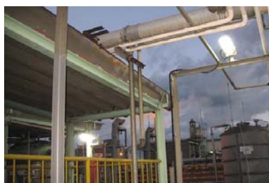
〔工場棟屋上／福山工場〕
