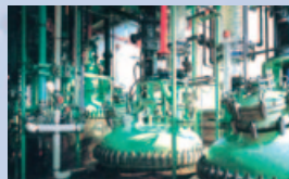
難燃剤大型プラント完成(平成4年)
